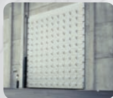
Puerta cortafuegos de grandes dimensiones 11 x 9mts
