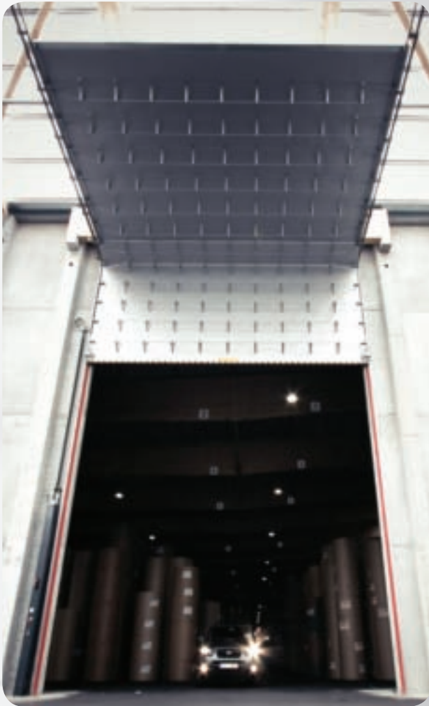
Puerta cortafuegos de grandes dimensiones
