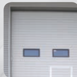
16. y 14. Mirillas y detalle de panel.
