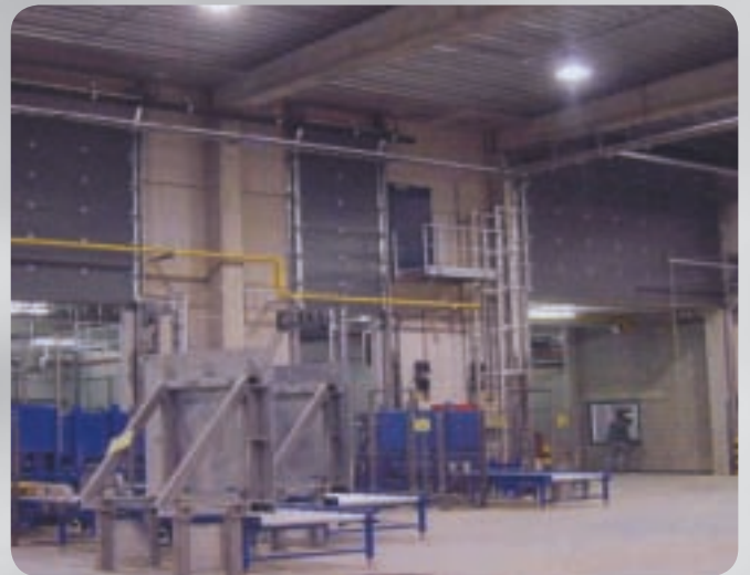
Puertas seccionales cortafuegos en almacén de mercancías con cintas de rodillos.
