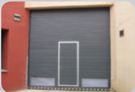
Sandwich con puerta peatonal y rejillas de ventilación.
